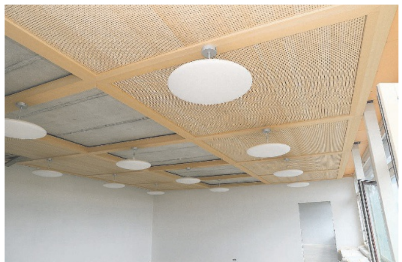
Im Musterzimmer sind die Akustikdecke und die LED-Beleuchtung montiert worden.
