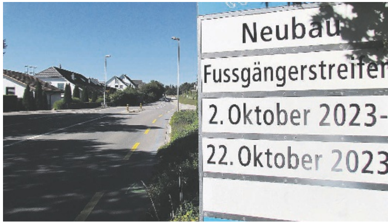
Aus dem bisherigen Fussgängerübergang entsteht ein Fussgängerstreifen.
