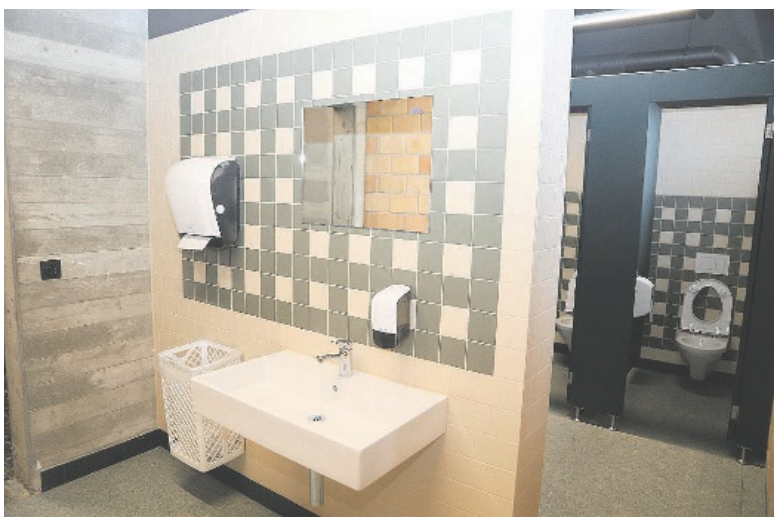
Die sanierten WC-Anlagen sind seit Mitte August in Betrieb.
