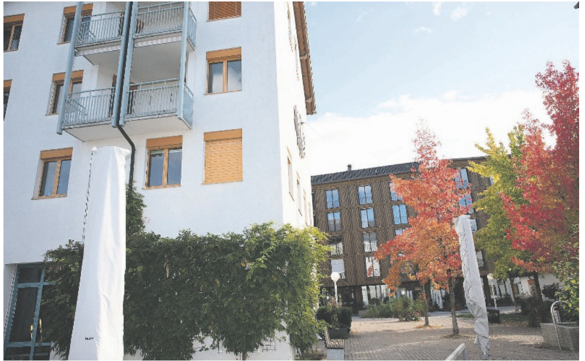
Im ehemaligen Pflegezentrum (links) finden derzeit Umbauarbeiten statt.
