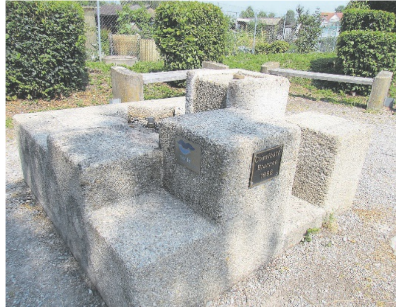
Wegen einer fehlenden Rückleitung darf der Chimlibach-Brunnen beim Rastplatz Hellwies in Hegnau aktuell gar nicht betrieben werden.
