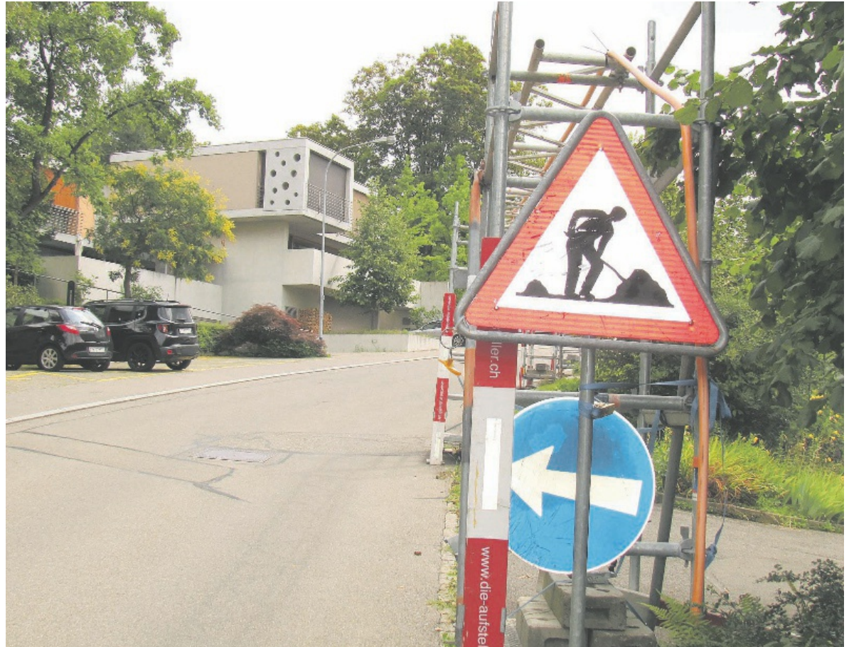
Der Gemeinderat hat einen Kredit für die Belagssanierung der Huzlenstrasse im Jahr 2024 bewilligt.
