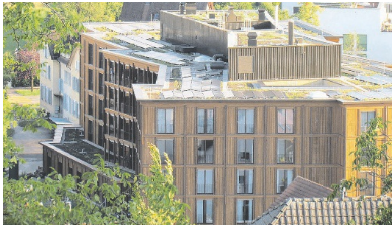
Am 2. September kann die Bevölkerung hinter die Kulissen des Neubaus blicken. BILD TSP
