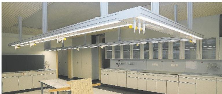
Der an der Decke befestigte Medienbalken in den beiden Chemie-/Physikzimmern ermöglicht ein flexibles Arbeiten mit Gas und Elektrogeräten.
