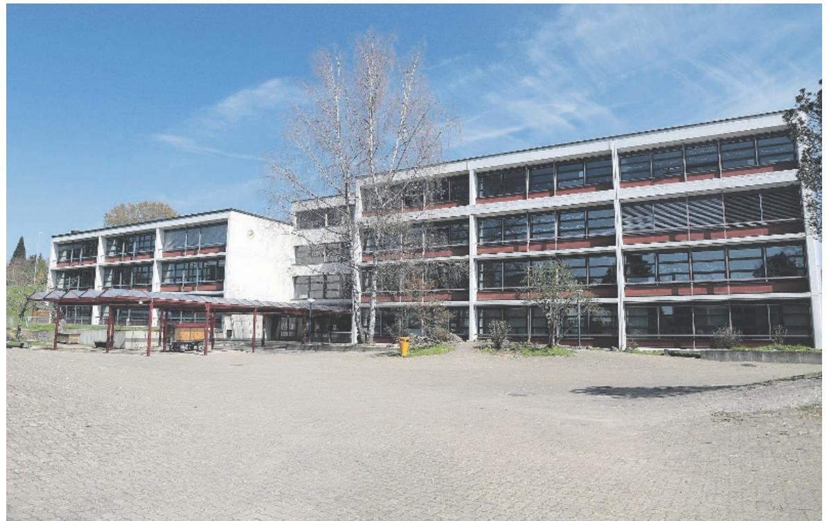
Soll ab 2025 saniert werden: die Schulanlage Feldhof.
