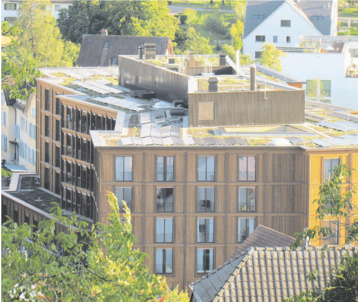
Blick vom Hausberg Hutzlen auf den Neubau der VitaFutura.
