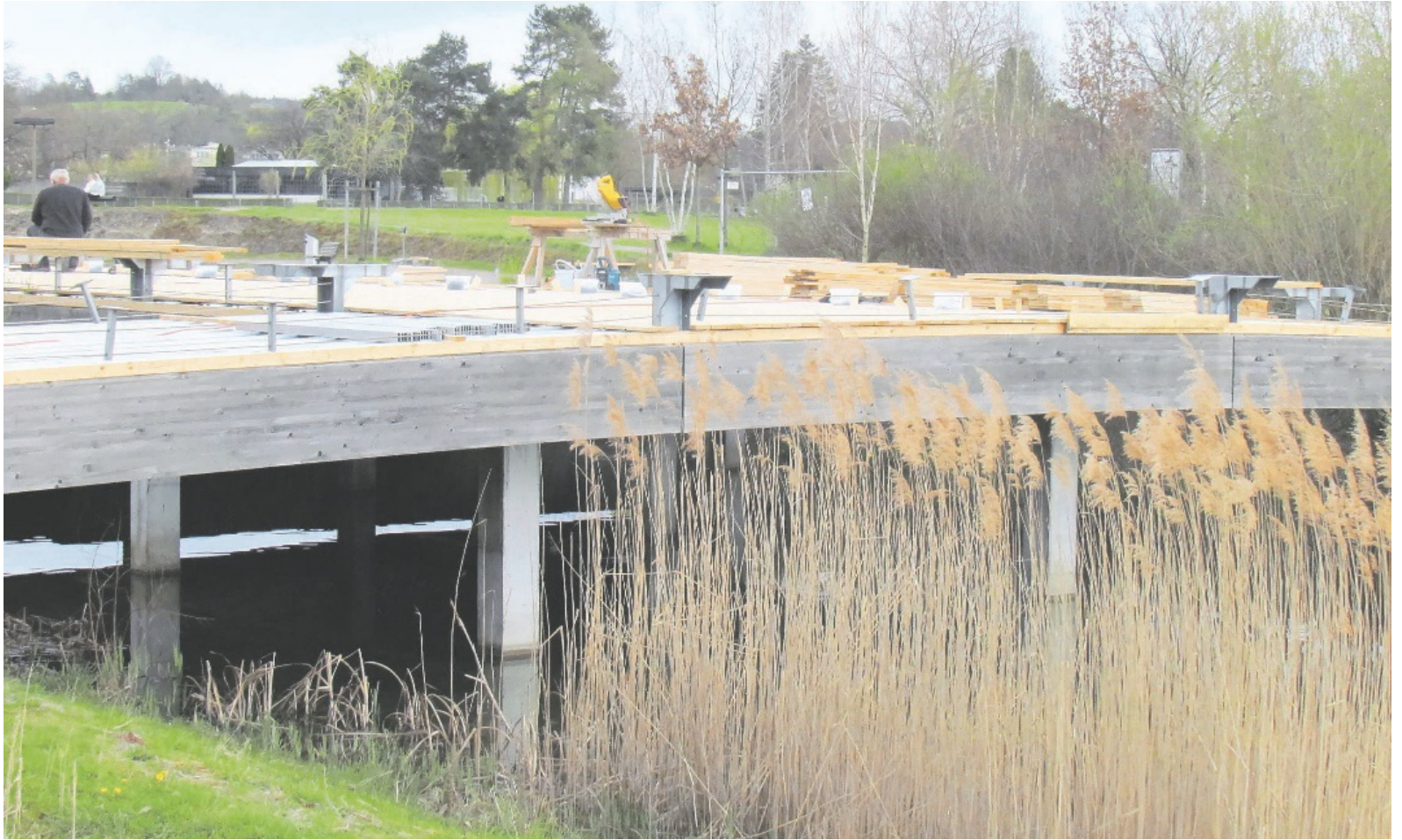
Die Brückensanierung im Griespark ist aufgrund eines schlechteren als ursprünglich angenommenen Zustands der Tragebalken teurer geworden.
