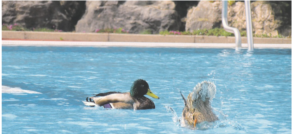
Die Becken im Waldacher sind sanierungsbedürftig, der Gemeinderat hat dafür einen Bauprojektierungskredit gesprochen. BILD TSP
