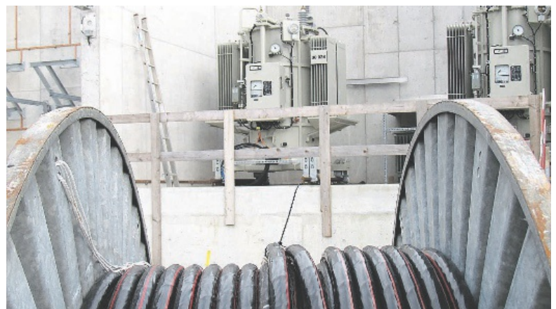
Blick auf die Baustelle des neuen Unterwerks in Kindhausen.
