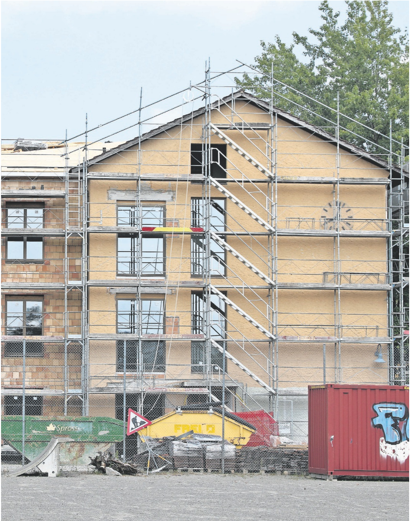
Das Schulhaus Zentral während der Sanierungsarbeiten im September 2021.
