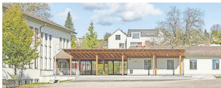
Bild 2: Situation Pausenhallendach angebaut an bestehendes Vordach.
