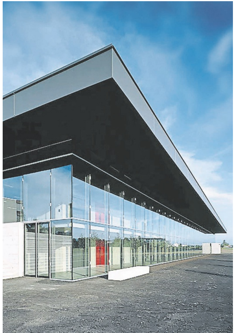
Abb. 1: Glasfassade mit Dachauskragung
