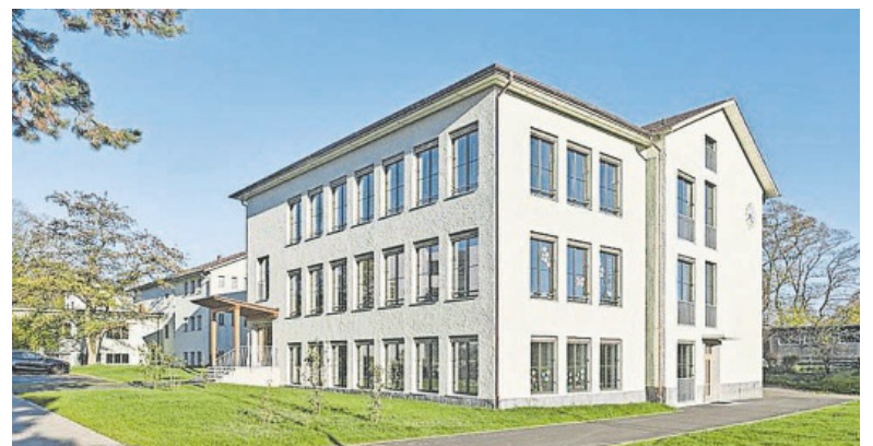
Bild 1: Anbau drei Klassenzimmer.
